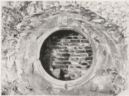
Fig. 9. Okno w budynku «Grodu».
