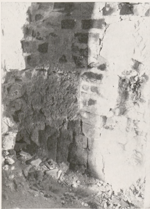
Fig. 3. Mur stołpu przy Kominku Wazów w sali «pod ptakami».
