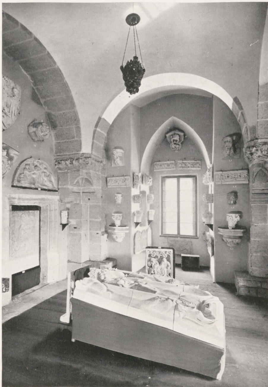
Fig. 10. Wieża ratuszowa. Wnętrze izby I piętra z widokiem na sztucznie wykrojone narożniki.
