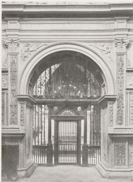
Fig. 17. Arkada wchodowa od wnętrza kaplicy.
