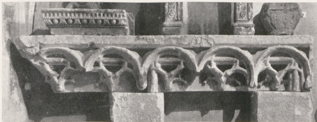
Fig. 8. Wieża ratuszowa. Gzyms rzeźbiony wyjęty z zewnątrz.
