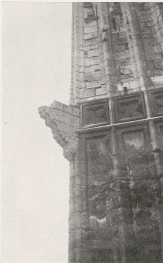
Fig. 4. Wieża ratuszowa. Konsola i część laskowania I i II piętra.
