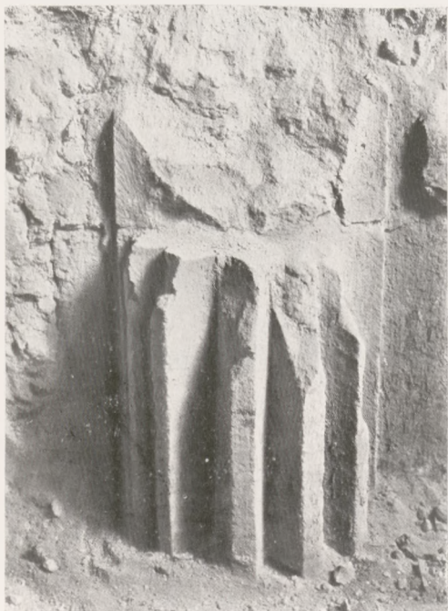
Fig. 15. Wspornik dawnego sklepienia w sali t. zw. «Alchemja».
