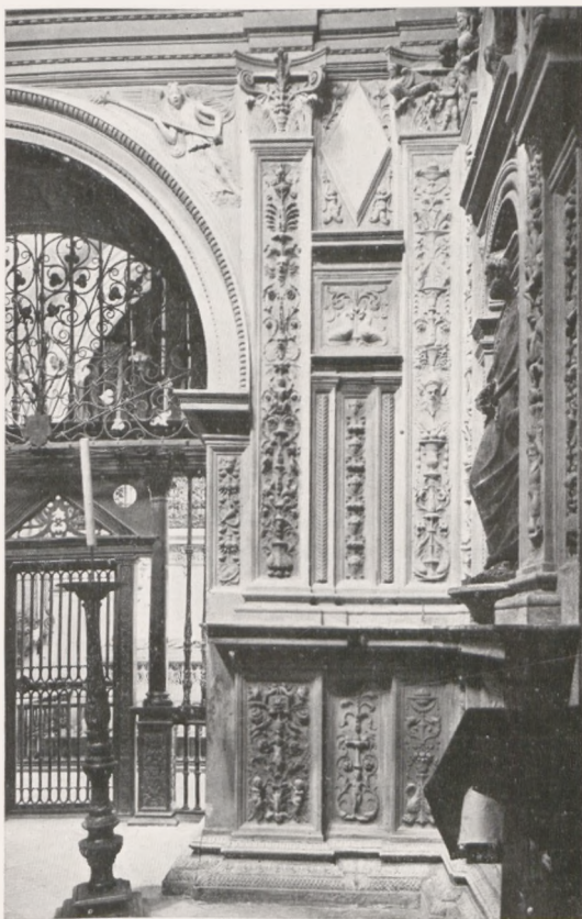
Fig. 18. Połowa ściany wchodowej.
