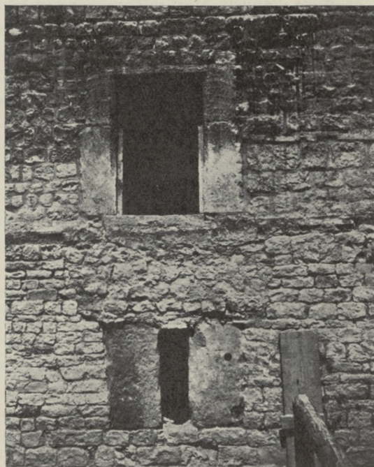
Okno romańskie (dolne) odkopane i okno gotyckie (górne) w ścianie południowej wieży Srebrnych Dzwonów. Fot. H. Kramkowski.
