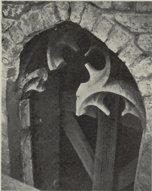
Okno gotyckie w wieży Srebrnych Dzwonów — przed restauracją. Fot. H. Kramkowski.
