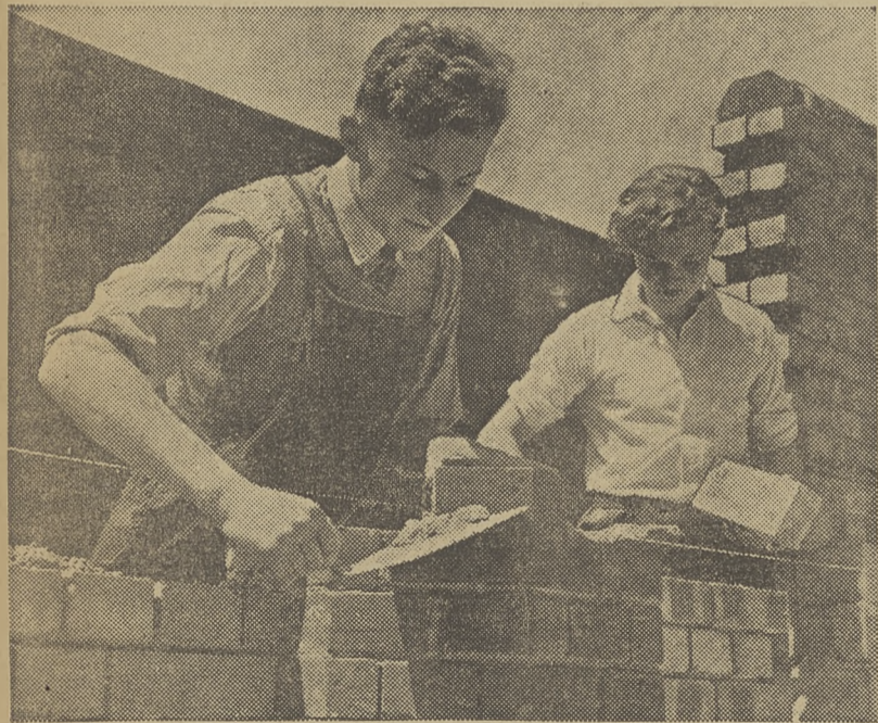
Szkola Rzemieślnicza: nauka układania cegieł — chłopcy ustawiają prosty mur.
