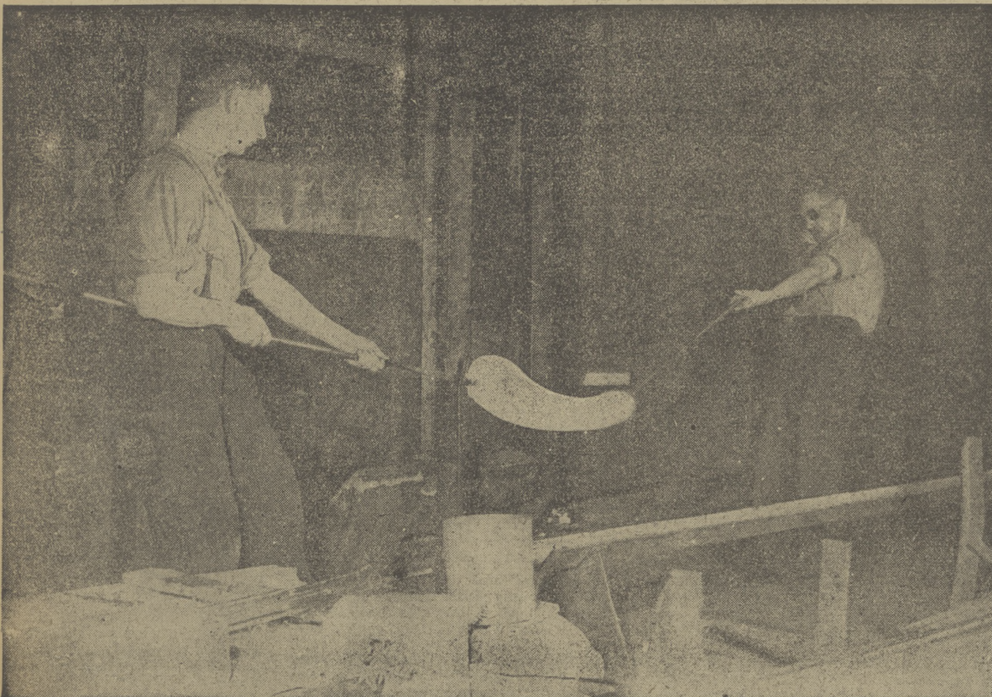
Powstaje szklana rurka. Robotnik po prawej stronie odchodzi od swego współpracownika, który bez przerwy dmucha, by rurka będąca w stanie kleistym nie wygięła się.
