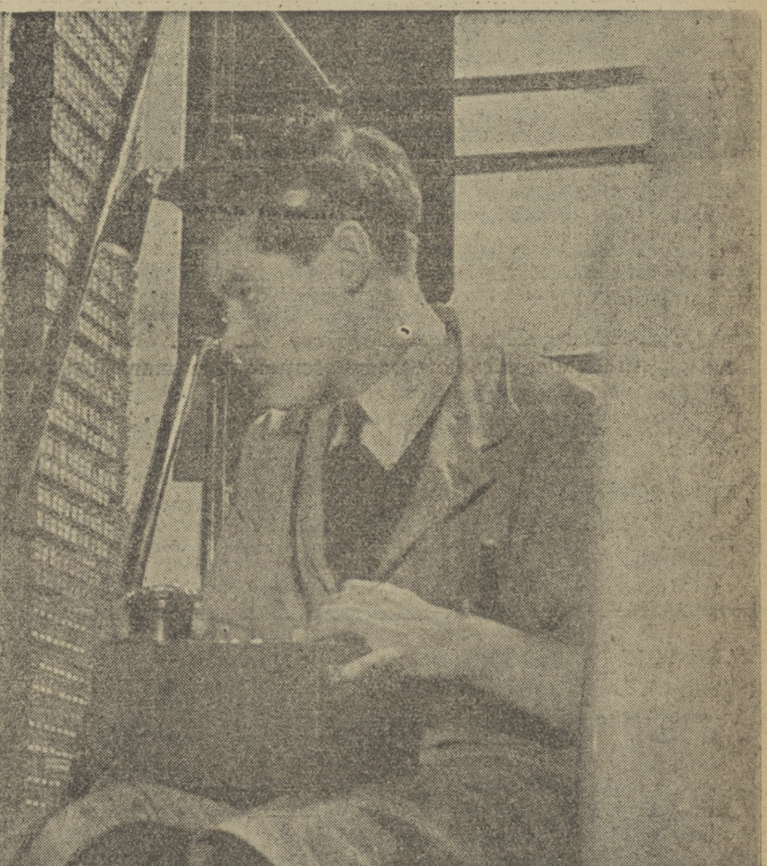
Linijki abonentów. Kiedy końcowy wybierak włączy się do wolnej linii, dzwonek automatycznie dzwoni pod wybrany numer, a sygnał połączenia automatycznie daje znać osobie, która nakręcała ten numer.
