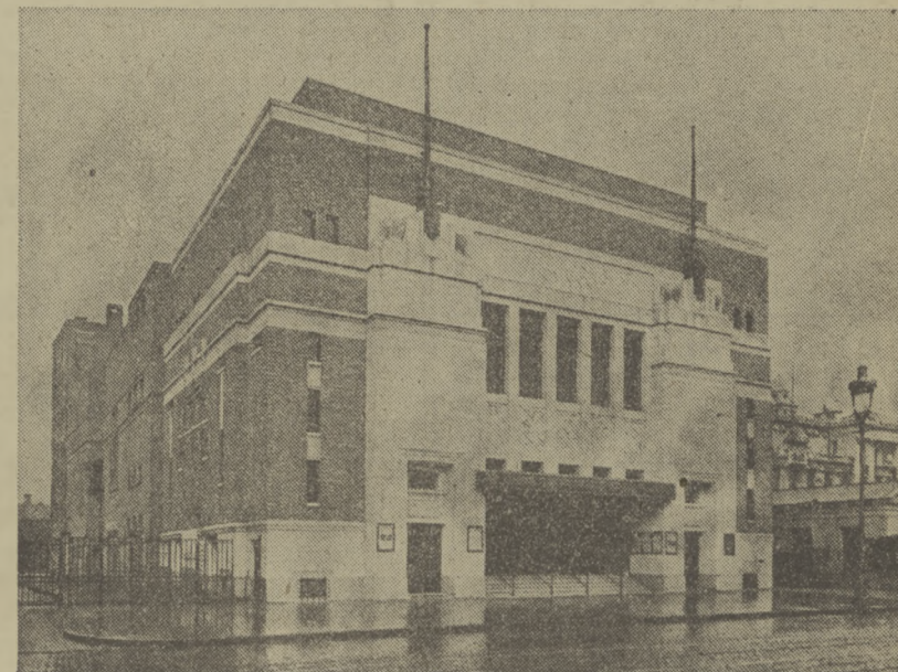
Dom kultury przy ulicy Mile End Road, East London. — Płaskorzeźby umieszczone powyżej daszku z brązu symbolizują różne zajęcia, wykonywane w domu kultury.
