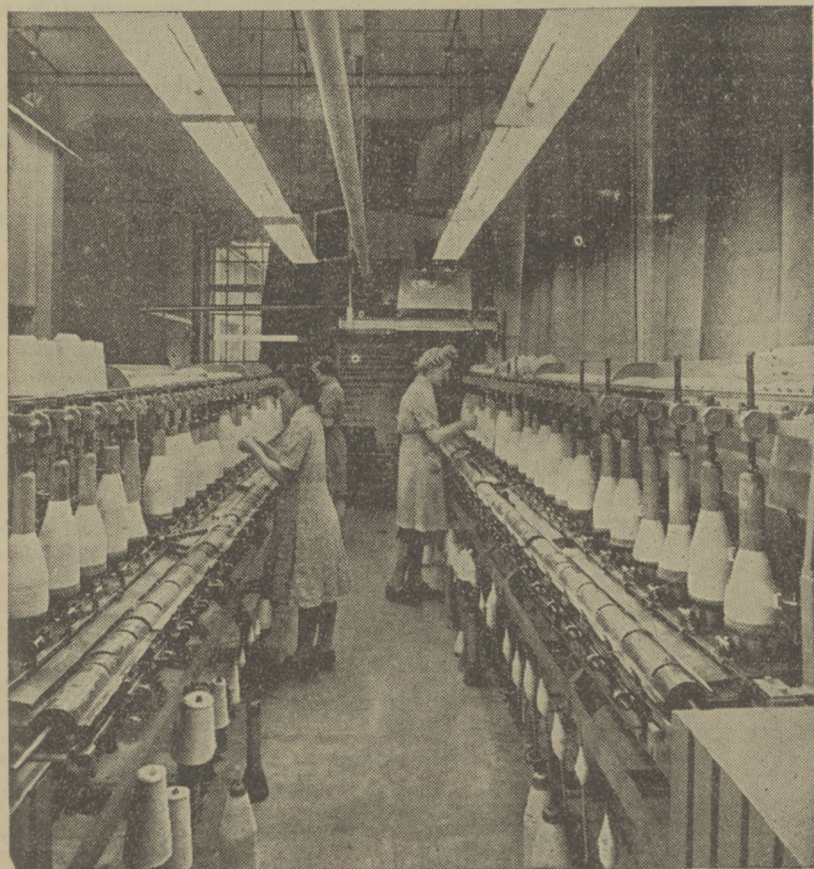
Przędzalnia. Daszki nad lampami zapobiegają rozpraszaniu się światła.
