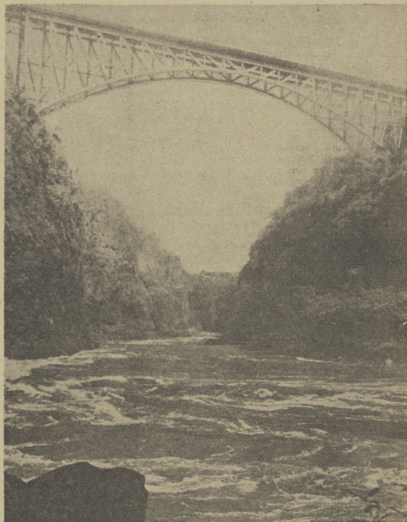
Stalowy łuk mostu nad przelomem rzeki.
