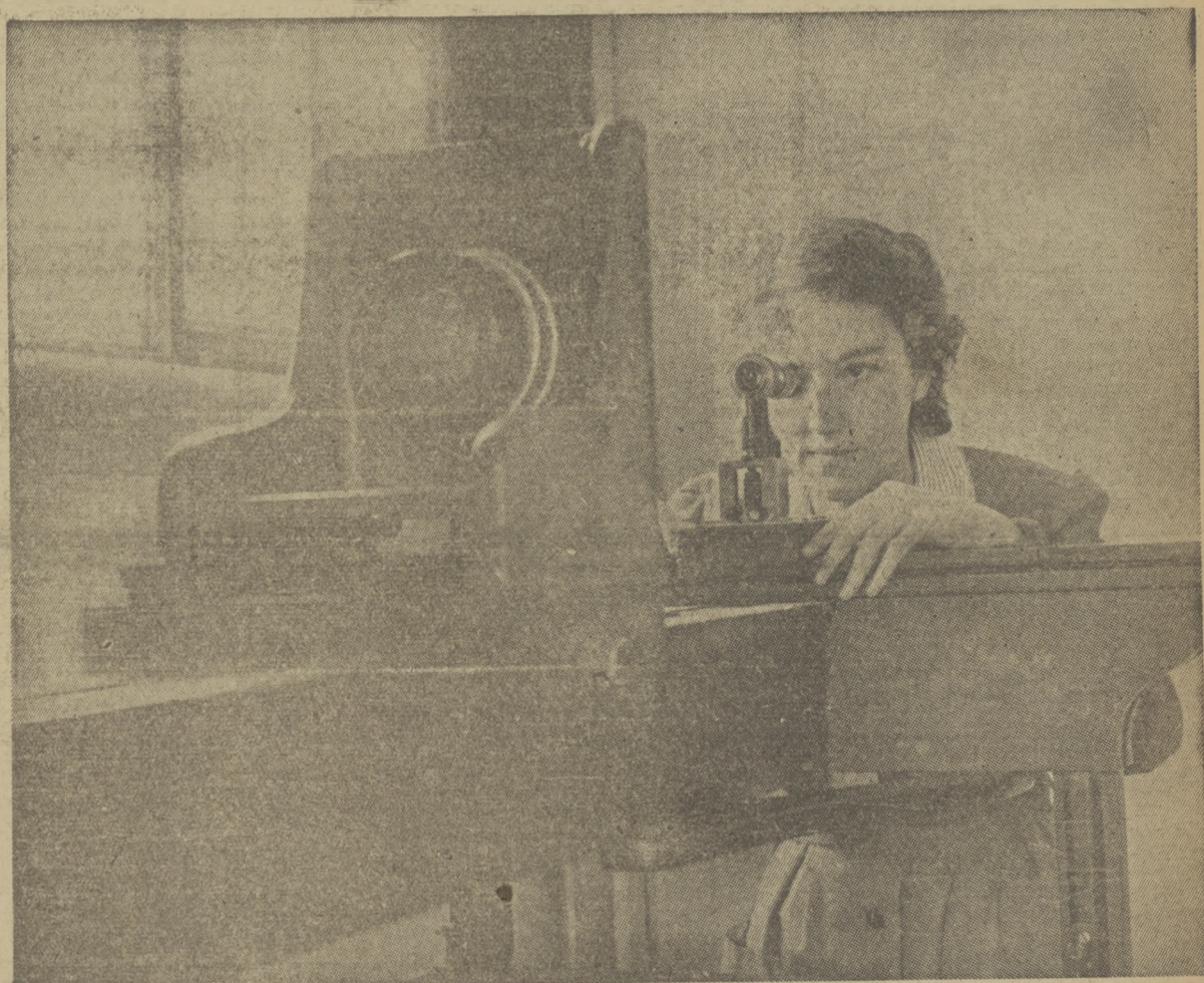
Gotową soczewkę bada się raz jeszcze przez mikroskop.
