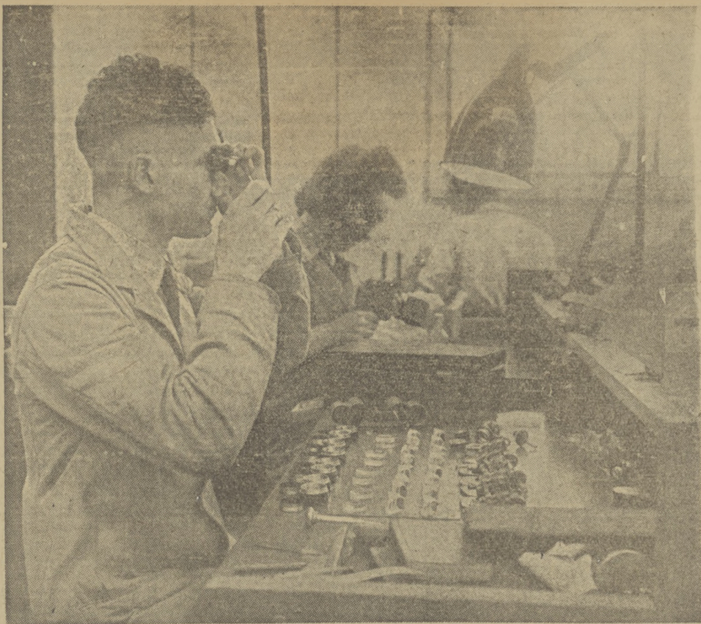
Najmniejsze zanieczyszczenia soczewki usuwane są przy pomocy szczoteczki, zrobionej z sierści wiewiórki.
