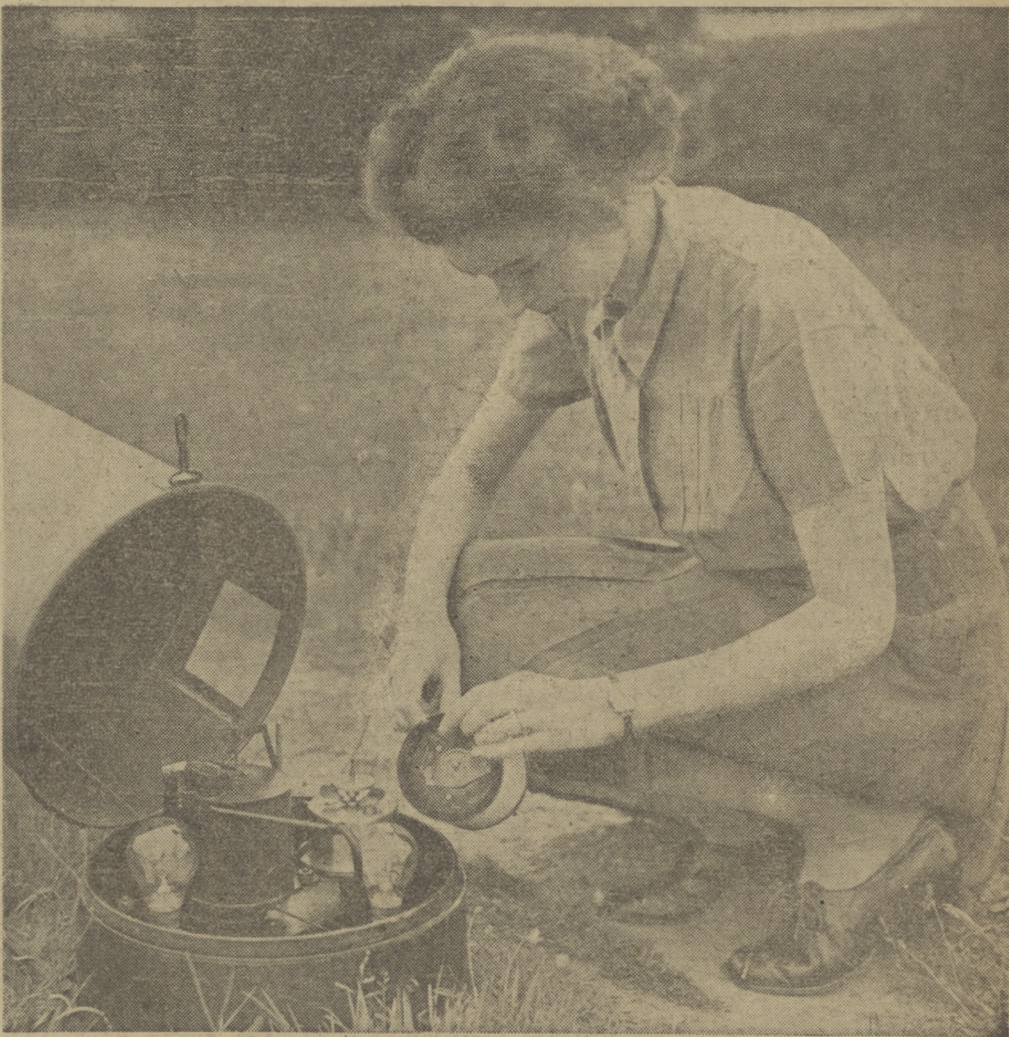
ZMIANA KARTY W AUTOMATYCZNYM DESZCZOMIERZU. ELEKTRYCZNE ŻARÓWKI ZAPOBIEGAJĄ ZAMARZNIĘCIU WODY W ZIMIE.
