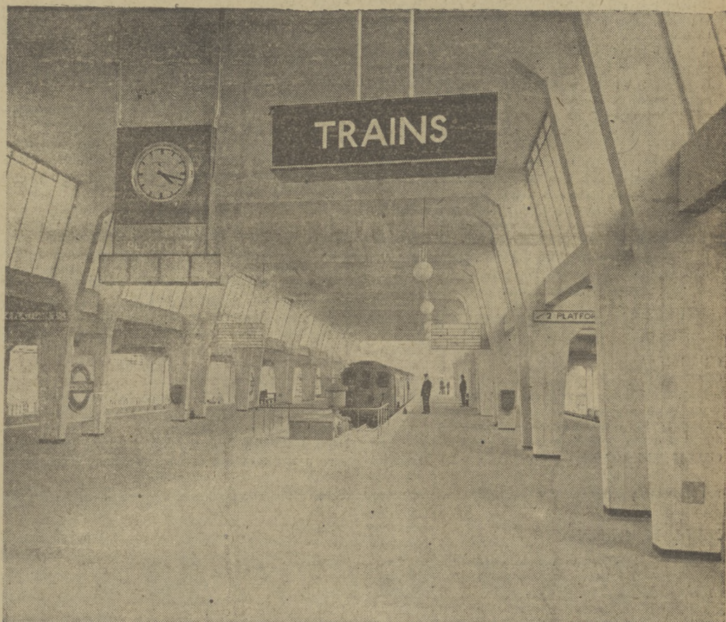
KOŃCOWA STACJA KOLEI PODZIEMNEJ.
