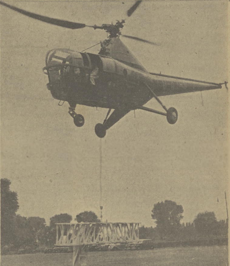
Na próbnym locie tego śrubowca wykazano, jak można ułatwić budowę małych mostów przez przenoszenie przęsła
