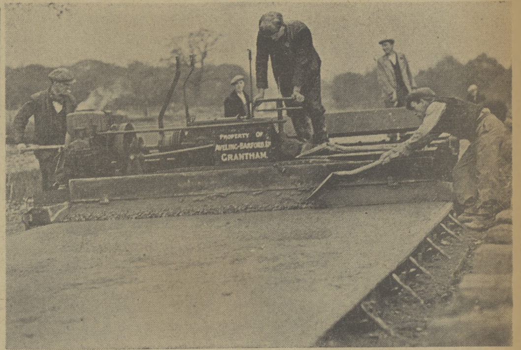
Nowy typ maszyny do nakładania nawierzchni betonowej.
