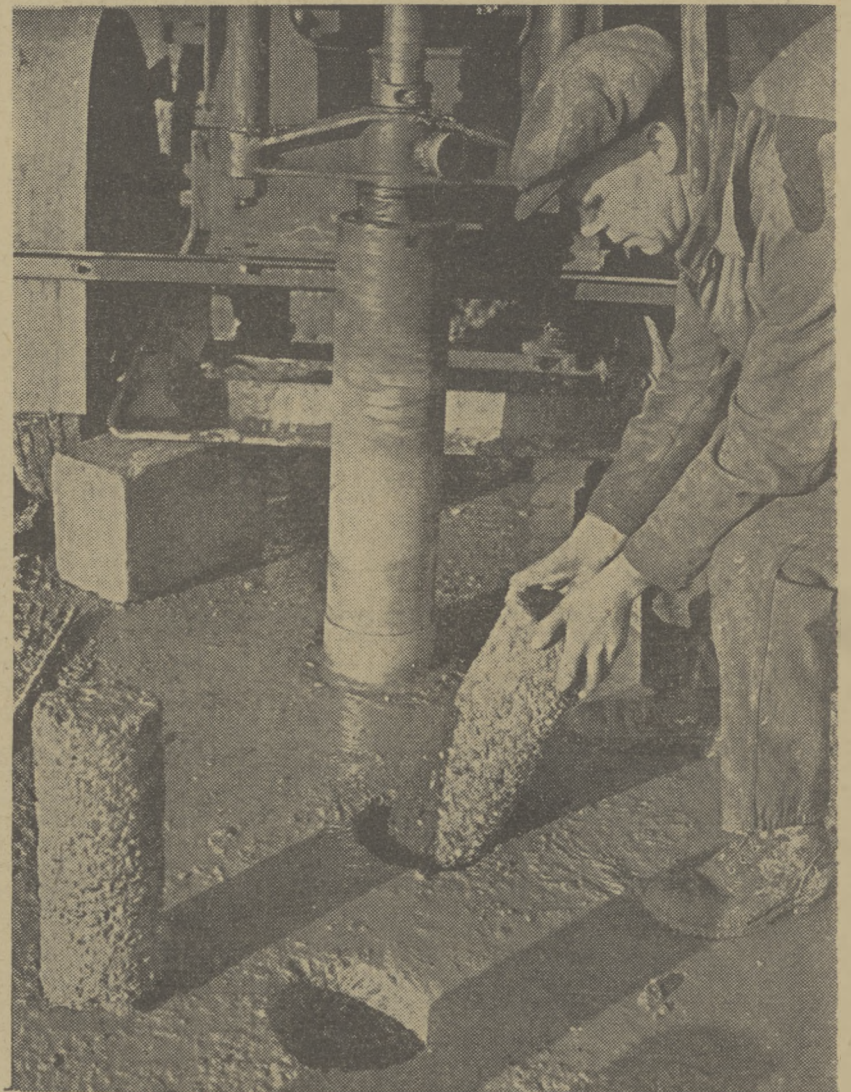
Maszyna do wiercenia otworów w betonie.
