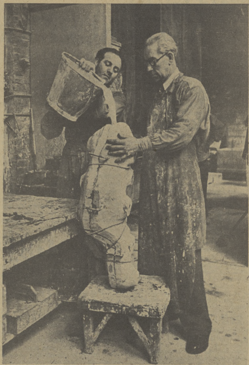
Wlewanie ogniotrwałego „rdzenia“ do formy.
