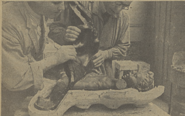
Gdy „rdzeń“ stwardnieje, otwiera się formę.
