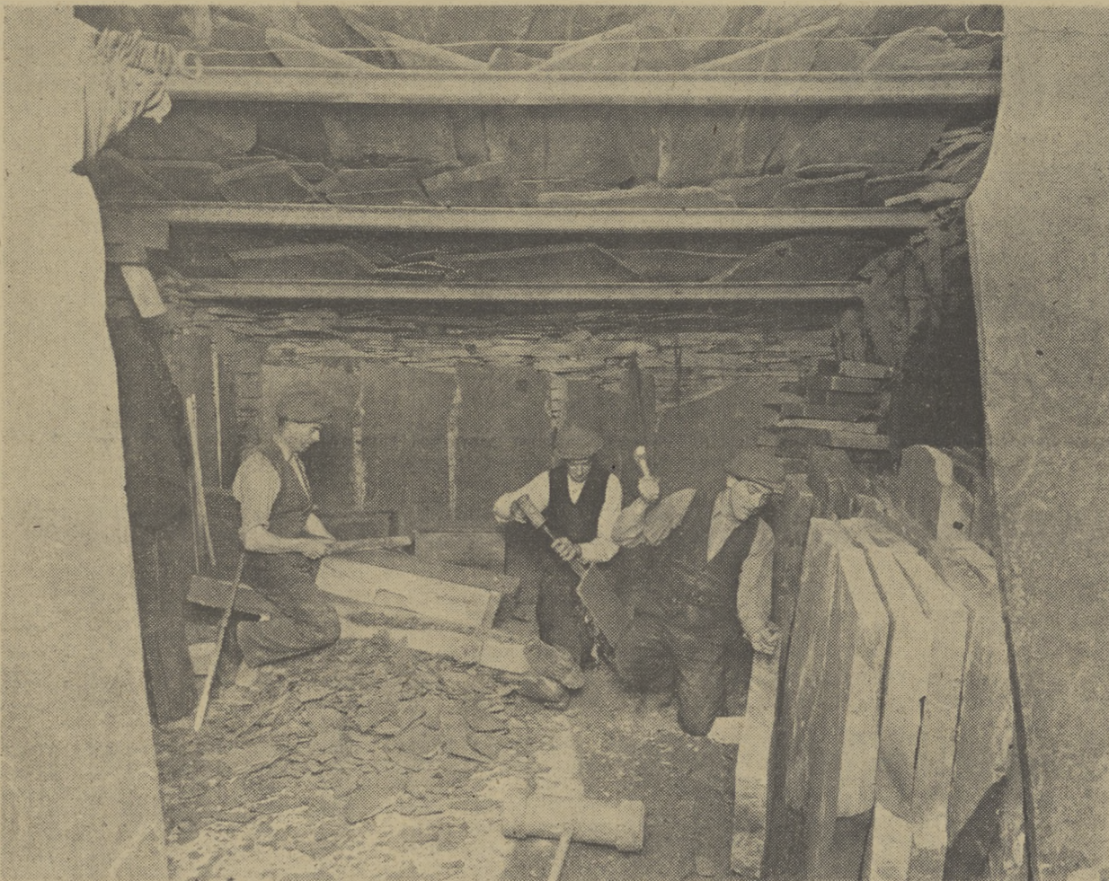
Rozłupywanie płyt łupkowych i przycinanie ich na dachówki.
