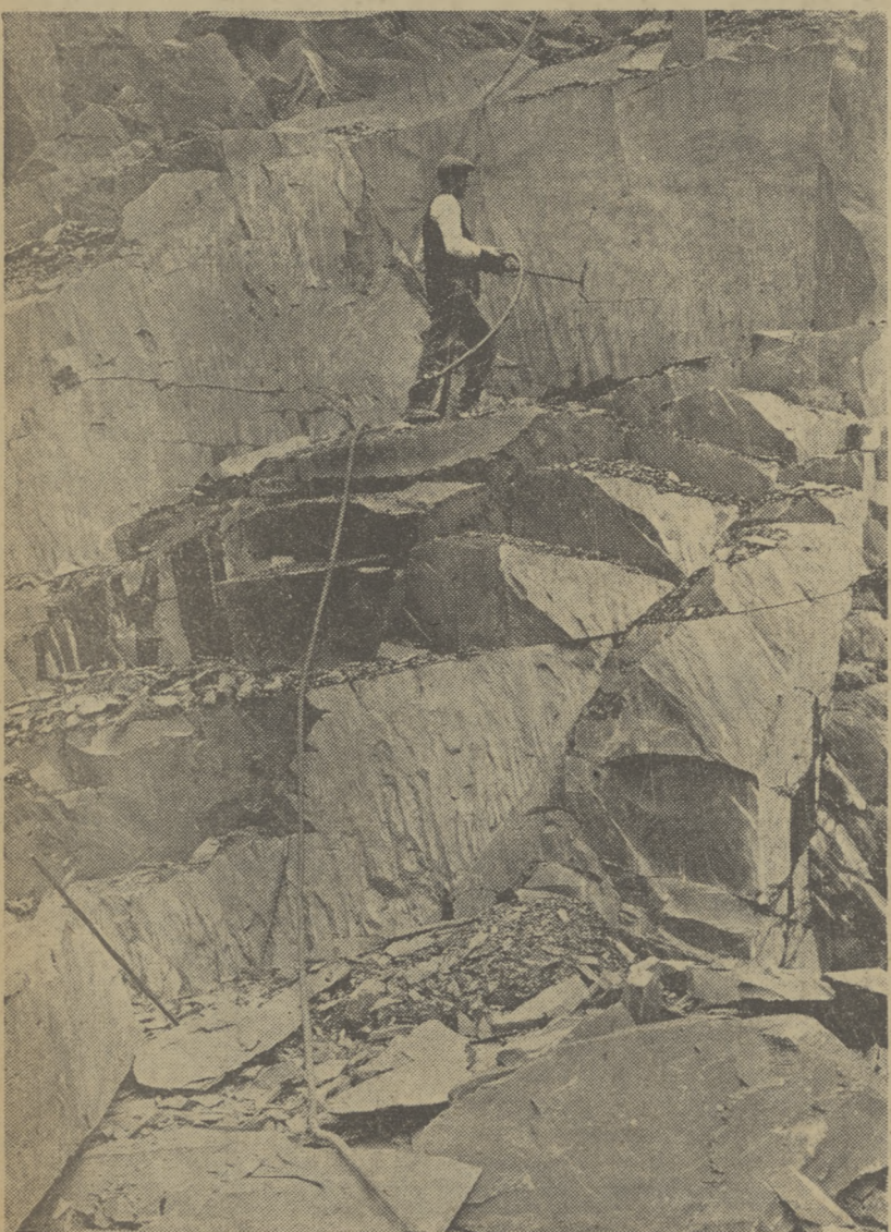
Drążenie skały przy pomocy wiertarki.
