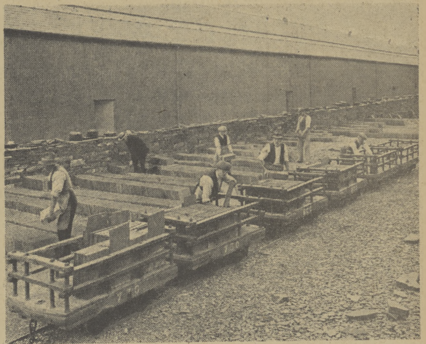
Układanie dachówek na wagoniki, które wożą transport do portu Dinornic.
