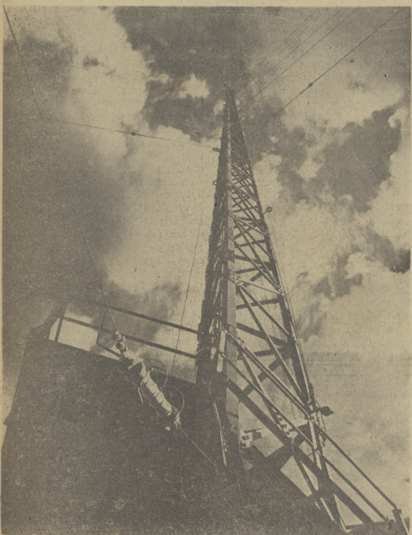
160-metrowy maszt radiostacji londyńskiej.
