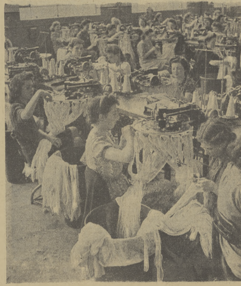
W fabryce pańczech. Dziewczeta przyszywają „stopy” do uformowanych „tydek”.
