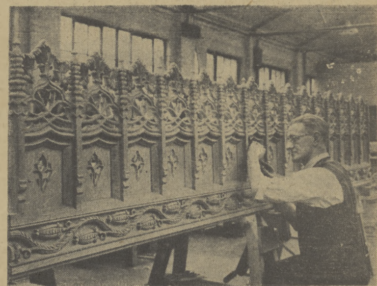
Zdolni rzemieślnicy pracują obecnie nad rzeźbami, które ozdobią wnętrze nowego gmachu Izby Gmin. Do prac tych użyto przeszło 800 m dębu angielskiego. Na zdjęciu: wykańczanie drewnianego fryzu dla gmachu Izby Gmin.
