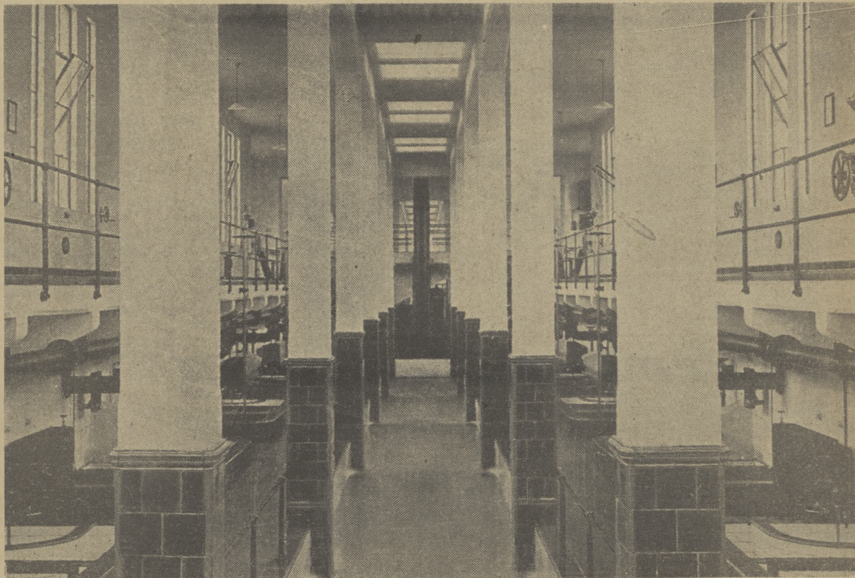
Filtry. Tu oczyszcza się wodę z wszelkich szkodliwych dla organizmu ludzkiego składników.
