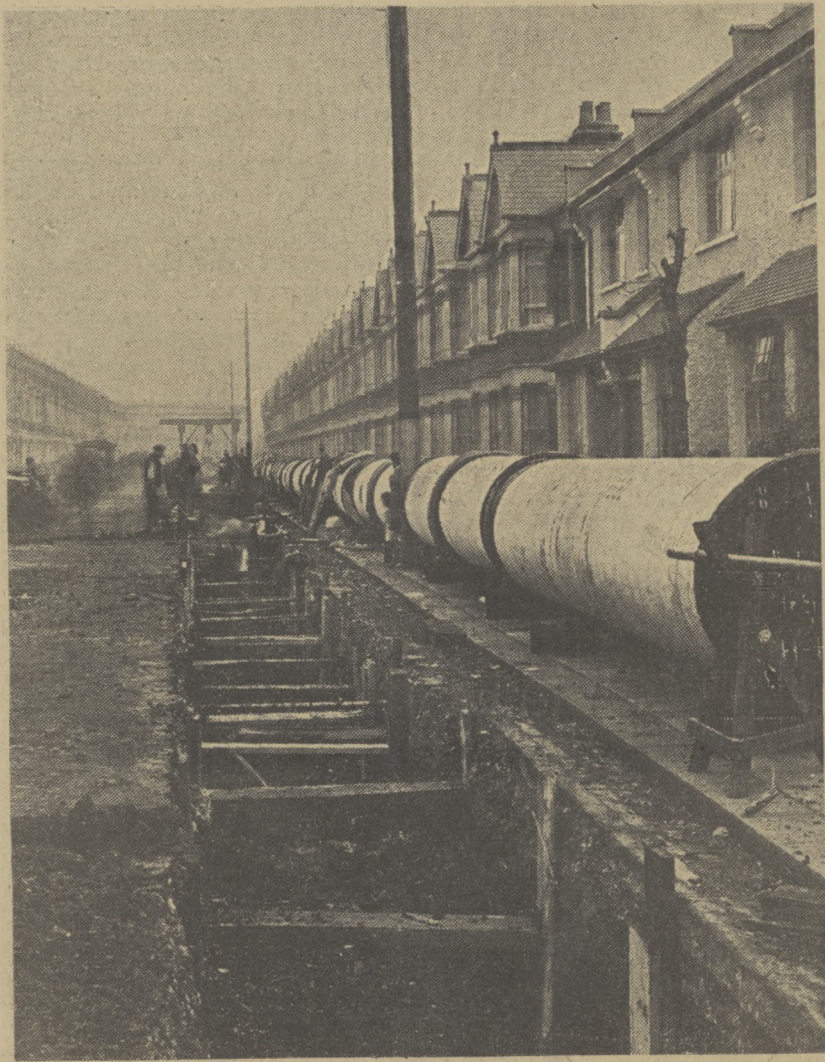
Rury gotowe do wpuszczenia w ziemię. Nowa dzielnica otrzyma wodę bieżącą.
