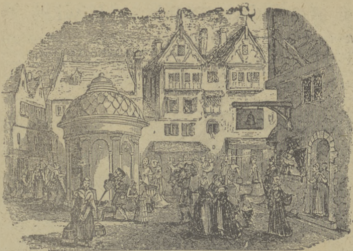
W XVI w. istniało w Londynie około 20 wodociągów. Okrągła budowla w centrum zamieszczonej powyżej ryciny, to właśnie taki szesnastowieczny wodociąg. Ciągną do niego całe procesje ludzi zaopatrzonych w konwie i dzbany.
