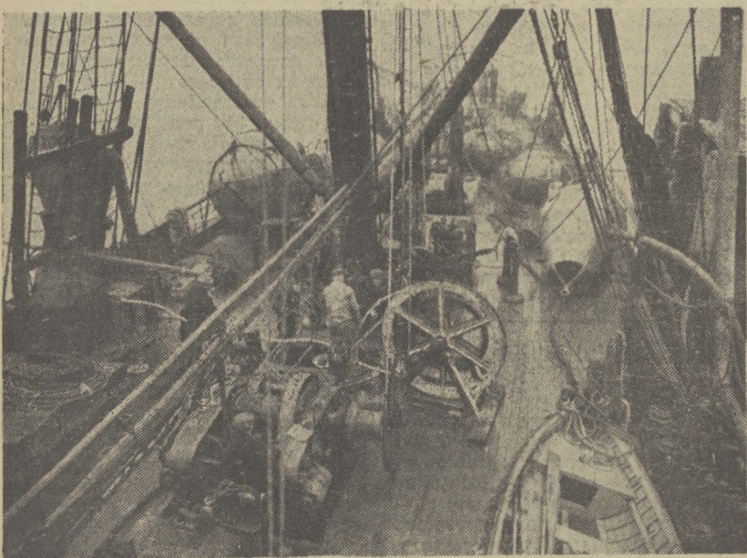
Przedni pokład statku z otwartą komorą kablony.
