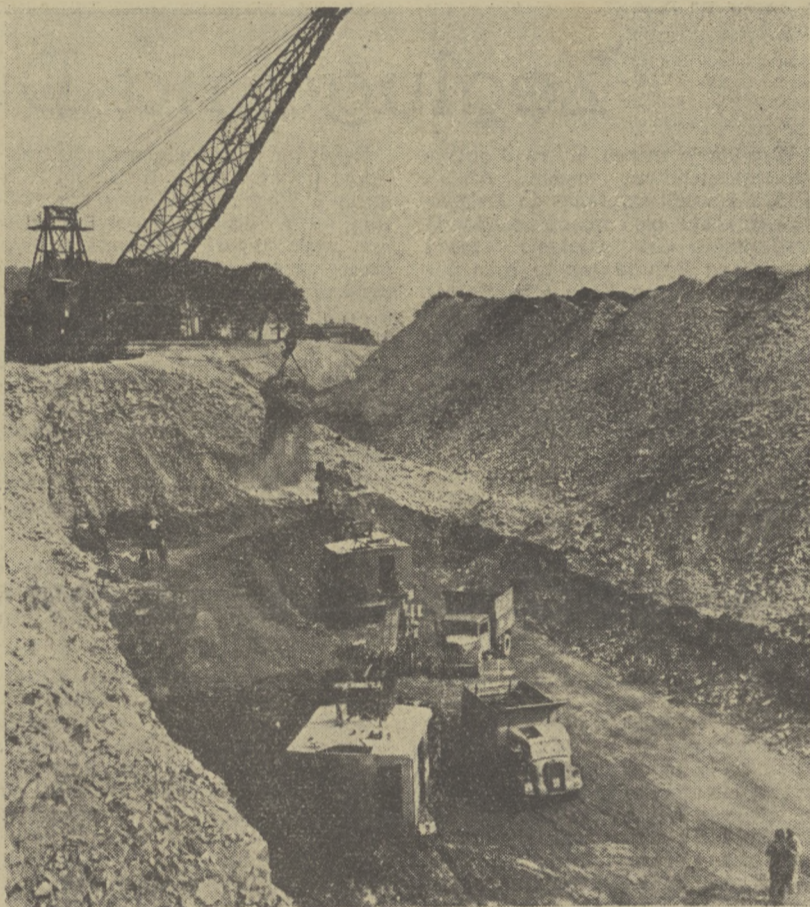
Praca metodą odkrywkową: oto wykop głębokości 9 m, ukazujący pokład węgla. Skoro pogłębiarki usuną ziemię przykrywającą węgiel, mechaniczne bagry zrzucają węgiel do wagoników.
