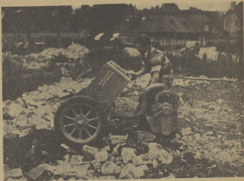
Taczki murarskie, służące do przewożenia betonu, ziemi, cegieł itd., posiadają napęd małego motorka benzynowego i są kierowane przez idącego obok nich robotnika.
