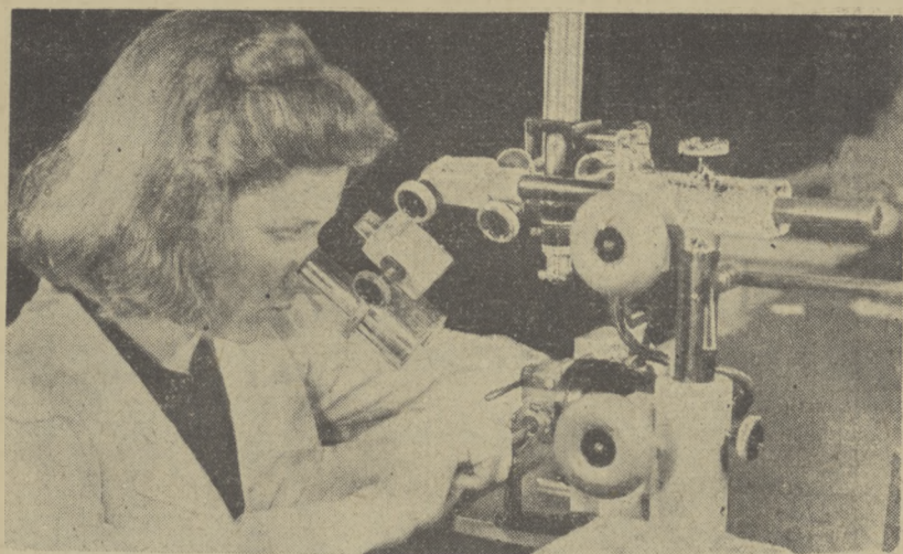
Robotnica wierci stożkowy kanalik w diamentcie ostrą igłą diamentową, którą trzyma w małych szczyppach. Postęp tej delikatnej operacji obserwuje przez szkło powiększające.
