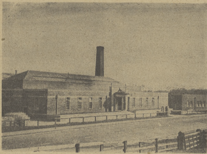
Langley Bridge, pierwsza centrala mleczna, obsługująca detalistów zgodnie z planem z 1943 r. Na zdjęciu budynek centrali pasteryzacyjnej, którą opuszcza 20.000 butelek na godzinę, a którą obsługuje 14 pojazdów z trzema cysternami o pojemności 13.500 litrów łącznie.
