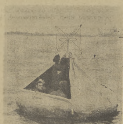
W razie niebezpieczeństwa nadętą już tratwę wyrzuca się na morze z pokładu statku. Za tratwę skacze w morze jej przysła załoga. Tratwa wyposażona jest w radar i wszelkie inne instrumenty nawigacyjne.
