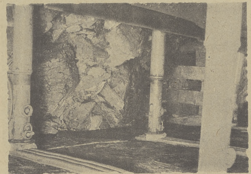
Stempie hydrauliczne podpierają pulap w przodku kopalni.
