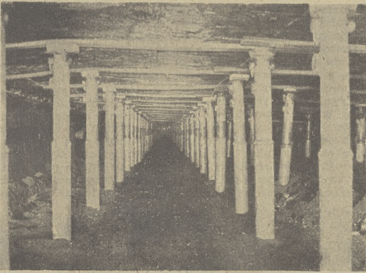
Chodnik, w którym zastosowano hydrauliczne stempie.
