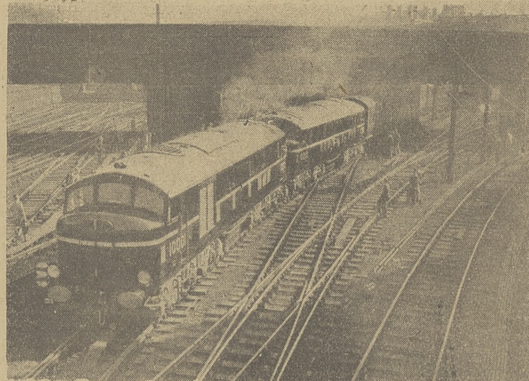
Dwie brytyjskie lokomotywy o napędzie Diesel-elektrycznym wyruszają z dworca Euston w Londynie w swą pierwszą podróż do Carlisle. Jest to początek ich normalnej codziennej pracy w komunikacji pasażerskiej. Parowozy te mogą rozwijać szybkość ponad 100 km/godz.
