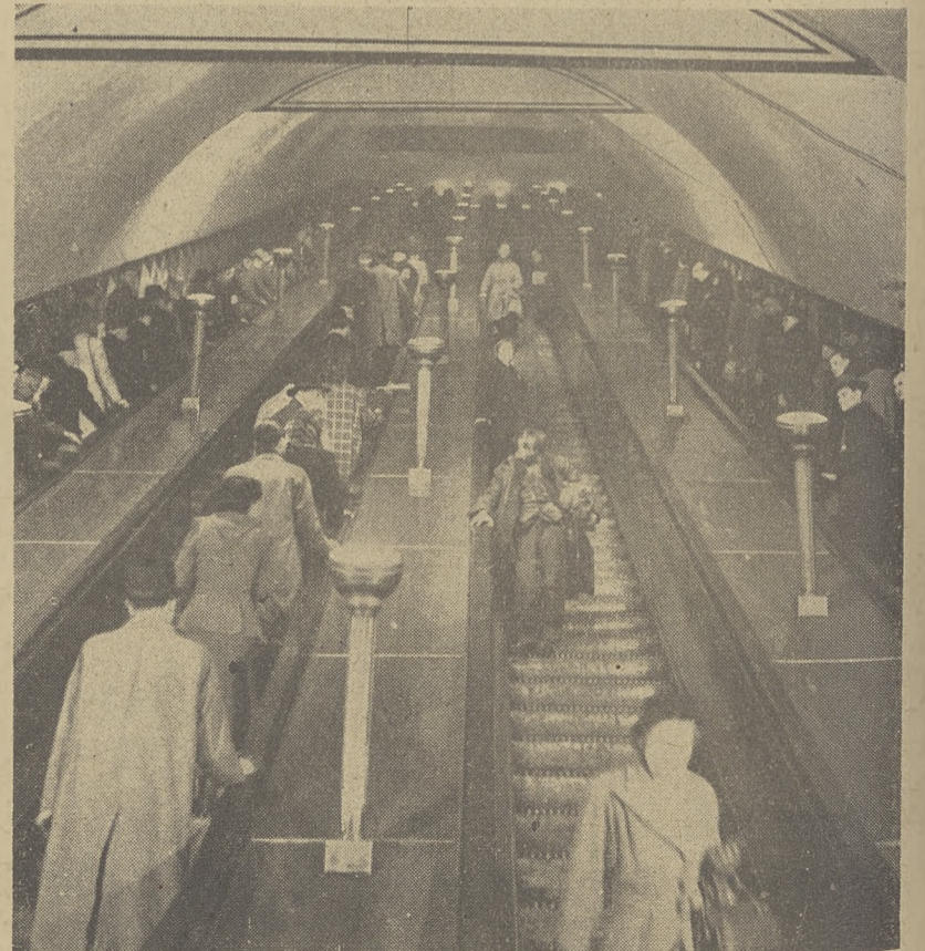
3 z 4 kondygnacji ruchomych schodów poruszają się w jednym kierunku. 1 kondygnacja może pomieścić około 10.000 osób na godzinę.
