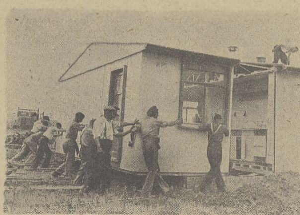
Ustawianie kuchni i łazienki na fundamentach.
