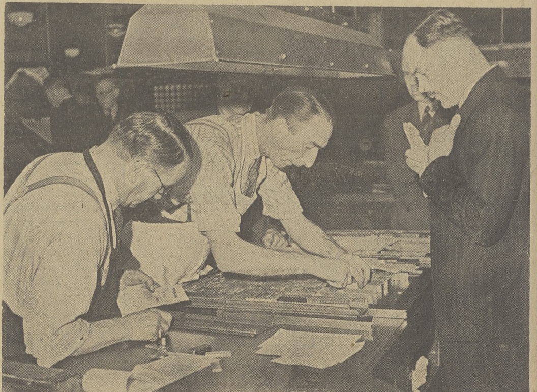
Metrampaż przy pracy.
