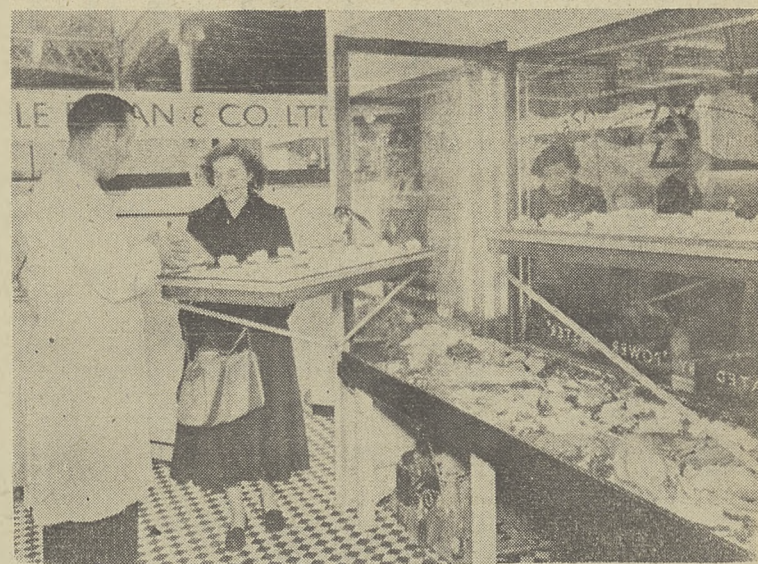
Na pewnej wystawie mleczarskiej pokazano nowy typ wystaw dla sklepów żywnościowych. „Podwójne” okna zapobiegają „poceniu się” szyb, zaś żywność leży na specjalnie zamrażanych tacach, które obracają się, by ułatwić obsługę wystawy.
