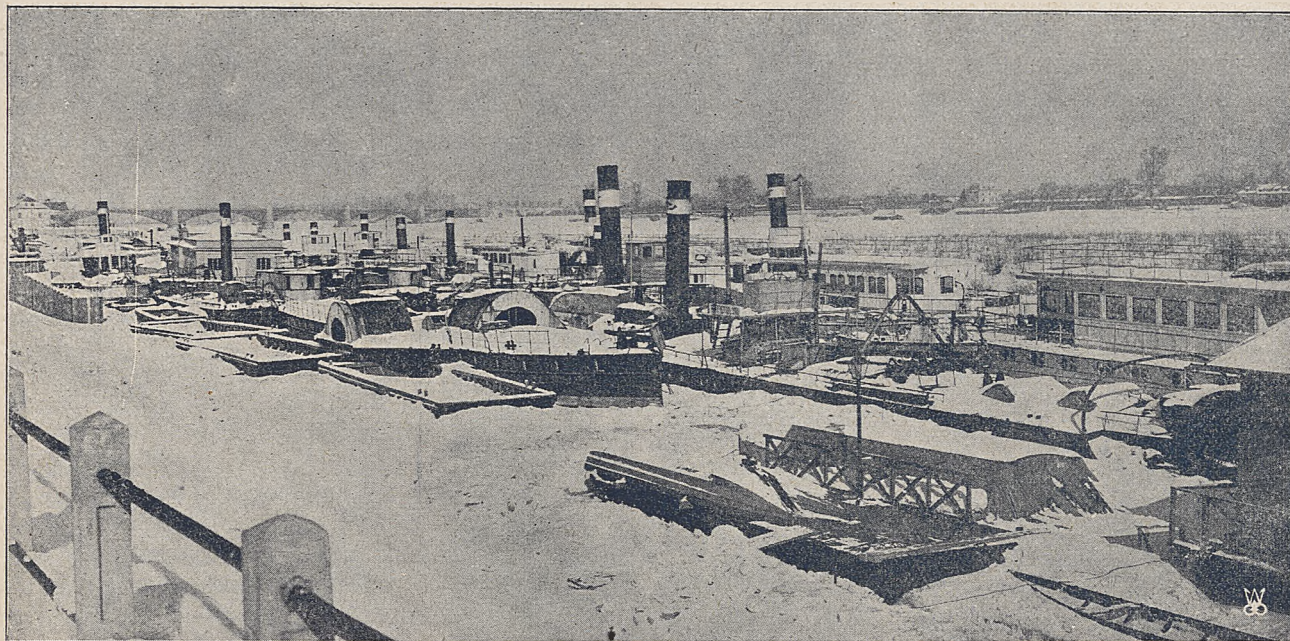
W połowie marca komitet powodziowy przystąpił do wyrąbywania lodu w porcie Czerniakowskim w Warszawie, gdzie statki zamarzły przeszło na metr głębokości i przy ruszeniu lodów mogłyby ulec zniszczeniu.
