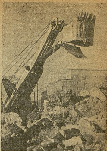
Prace nad oczyszczaniem terenu
