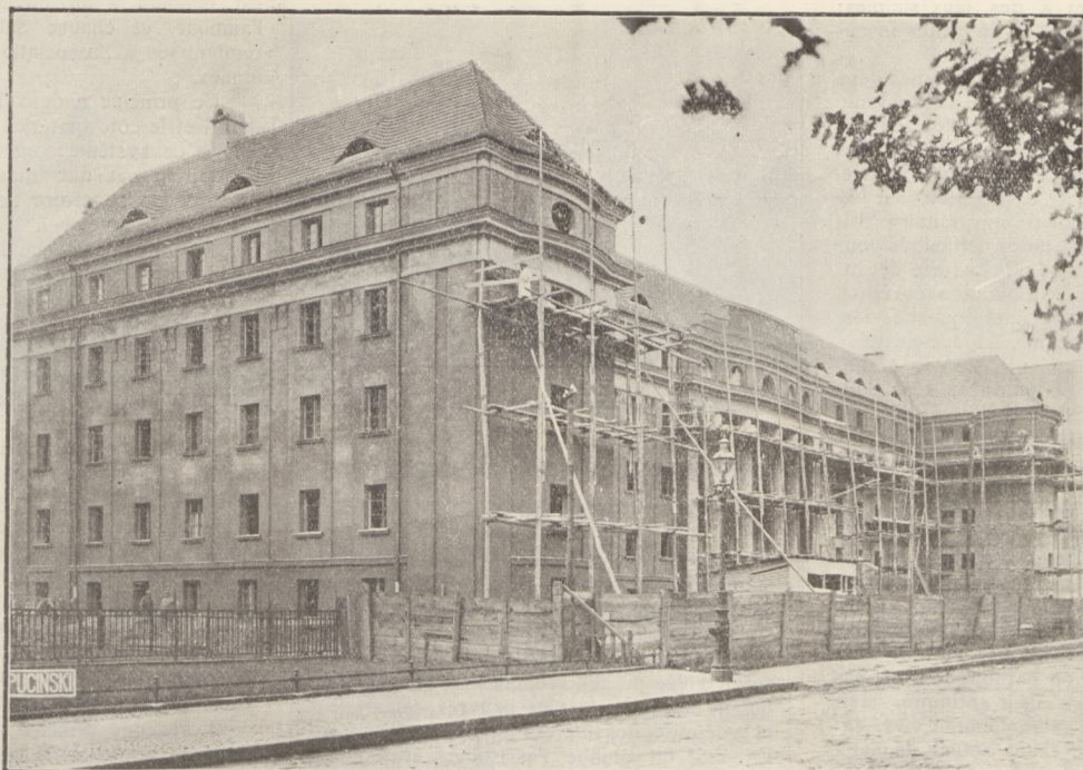
Maison académique en construction à Poznań.
