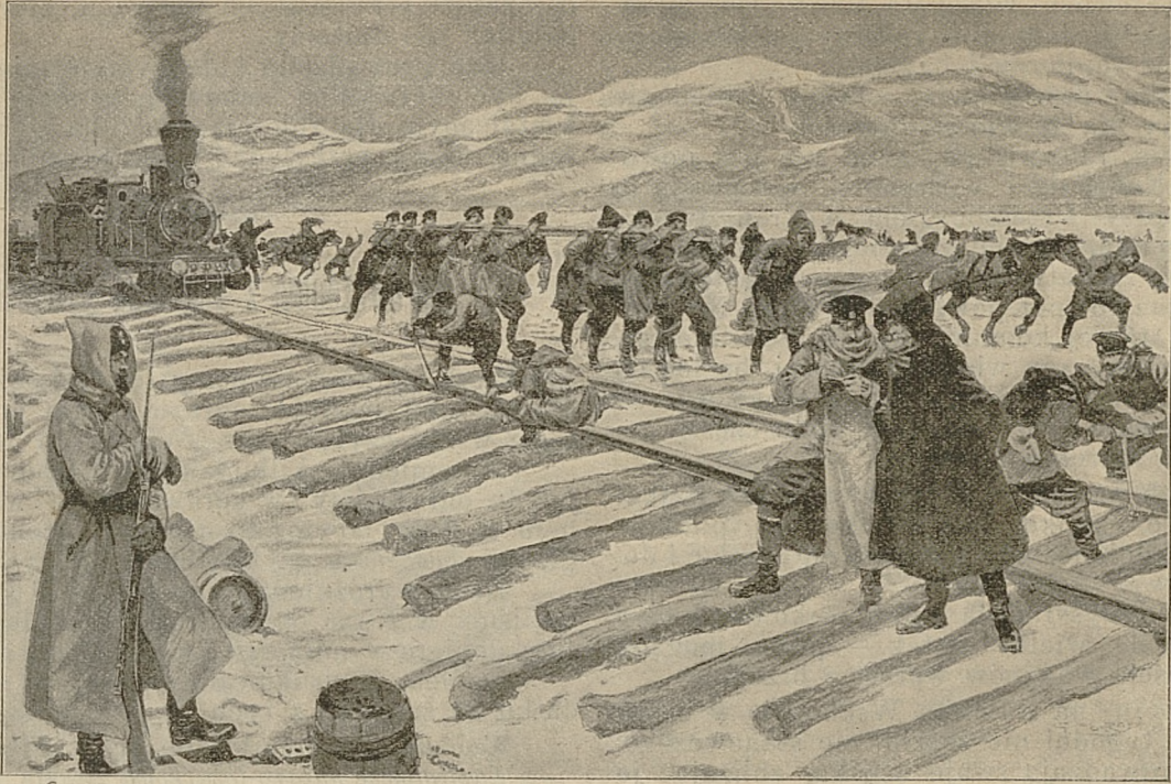
Układanie toru kolejowego na Bajkale.
