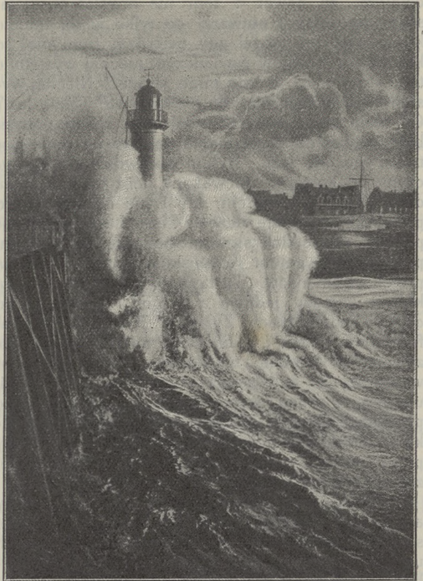
Grobla w Dieppe podczas burzy. Fale, jak wskazuje fotografia, przeskakują swymi potężnymi wierzchołkami przez groble, czyniąc ją niedostępną.
