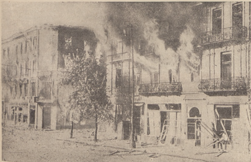
Silny obstrzał i brak wody nie pozwalał na gaszenie pożarów.
