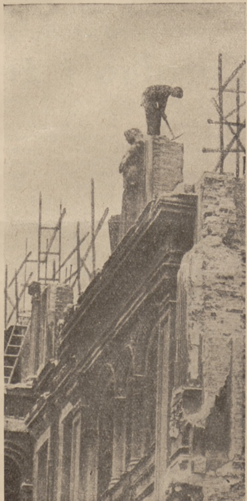
Rozbiórka ruin 5-piętrowej kamienicy na ul. Marszałkowskiej
