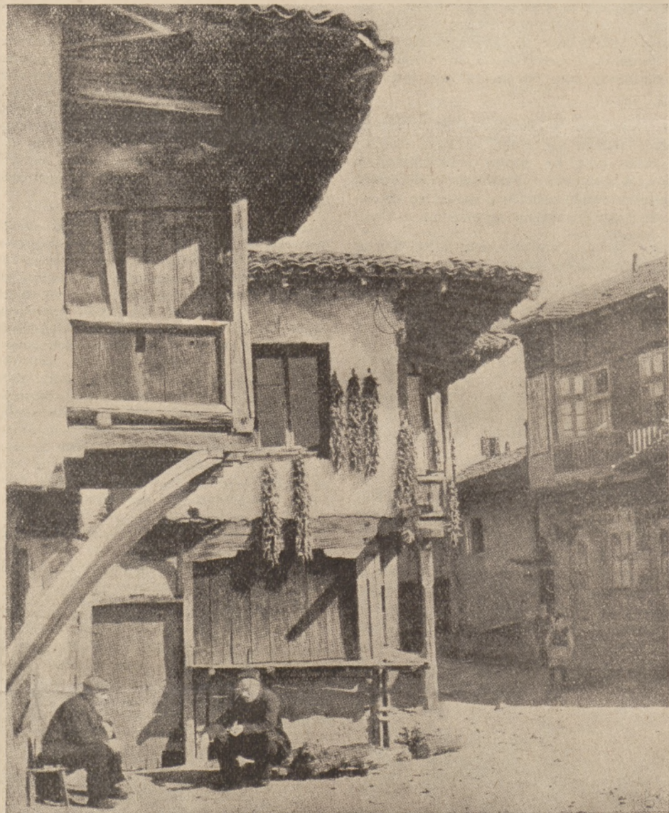
Charakterystyczna cecha budownictwa bułgarskiego są podcienia, balkony i płaskie, szerokie dachy, dające schronienie przed upałami
