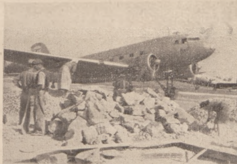
Odbudowa lotniska na Okęcu
