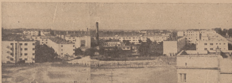
W klinie pomiędzy ulicami Krasieńskiego i Słowackiego w Warszawie na Żoliborzu odbudowuje się osiedle Warszawskiej Spółdzielni Mieszkaniowej. Część budynków została już oddana do użytku. W głębi budowana jest w szybkim tempie 11 kolonia mieszkaniowa. (fot. Ryteł-Szeliga)
