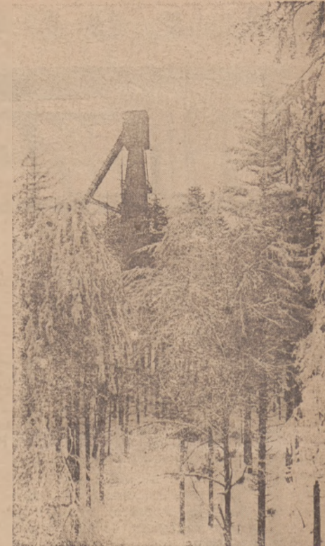
W ciszy leśnej, pośród oszronionych szczytów jodlowych samotna wieża wiertnicza.
