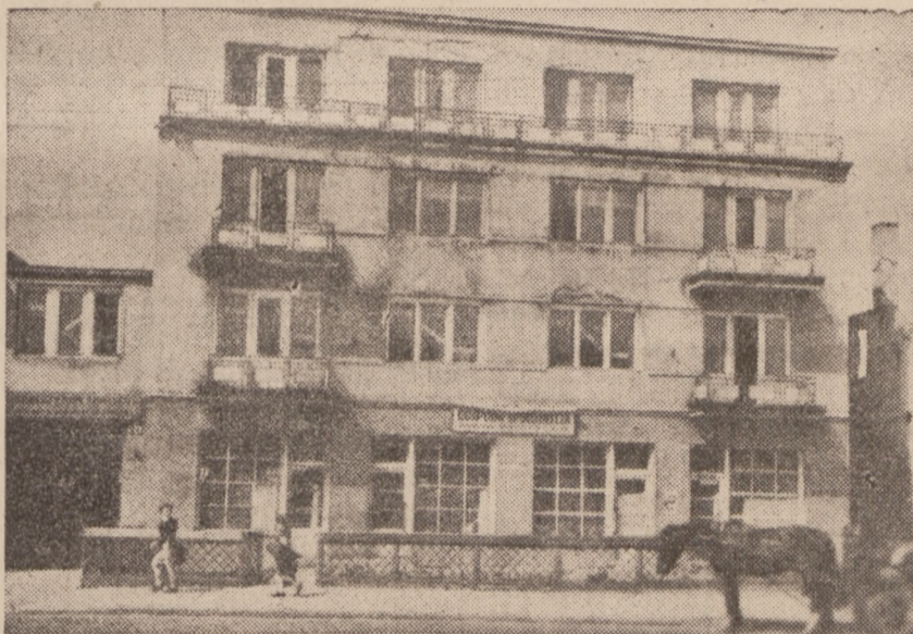
Opłony widok domu towarowego od strony Rynku Kościuszki
