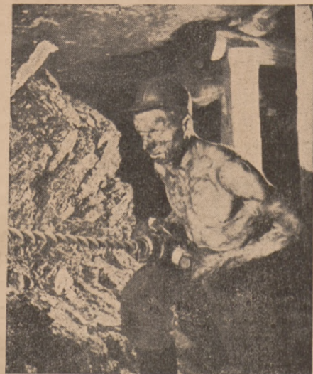
Kopalnia „Wujek” w Katowicach. Górnik wierci otwory w węglu w celu założenia materiału wybuchowego.
