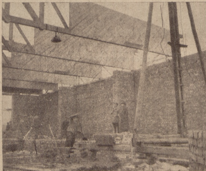
Budowa głównej hali w początkowej fazie.
