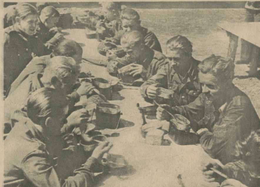
Ci młodzi ze „Służby Polce” przy pracy nad odbudową wybrzeża mają — jak widać — wcale nieżyły apetyt
