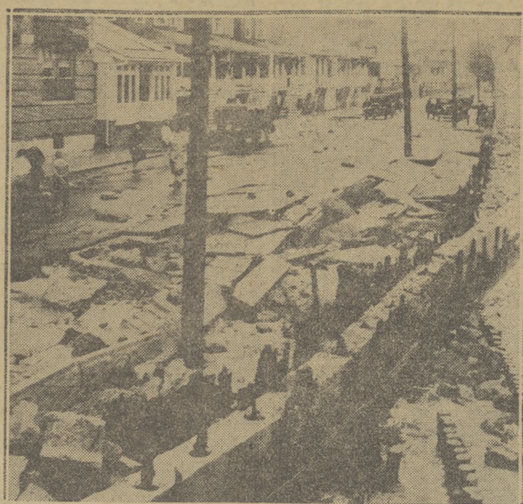
Silne tany betonowe, zbudowane wzdłuż wybrzeża oceanu w Atlantic City, N. J., przysły jak domki z kart pod naporem olbrzymich fal.
