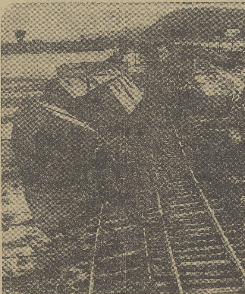
Widok zniszczenia wzdłuż głównej linii kolei Chicago-North Western w Honey Creek, Iowa, po oberwanu chmury. Zalew podmył tor kolejowy powodując wykołnienie pociągu towarowego. (Kliska Int. News).
