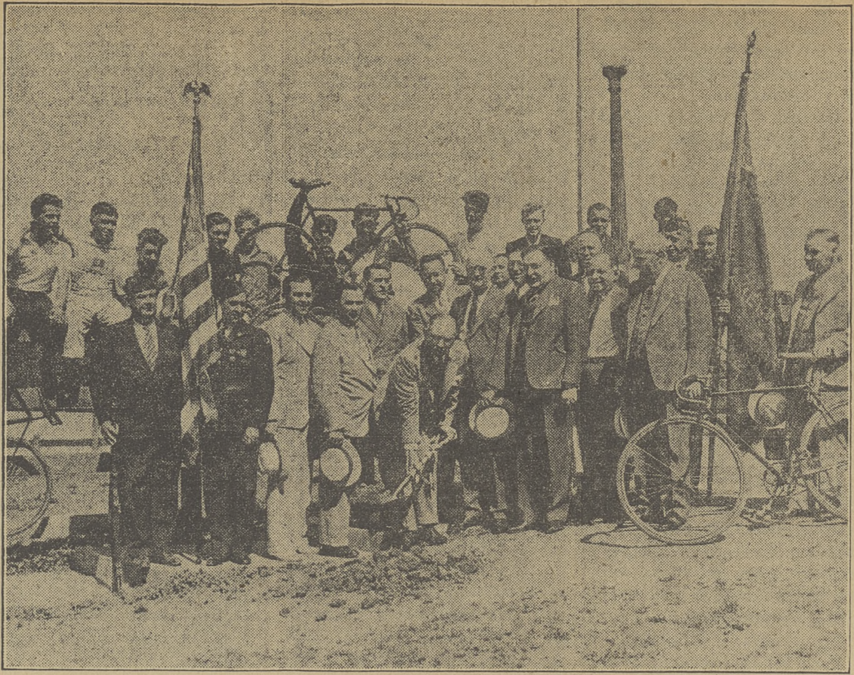
W Humboldt Parku oficjalnie rozpoczęto budowę nowego stadjonu sportowego, o jaki zabiegali Komisarze Alfred Flynn i Tomasz S. Gordon. Pierwszą łopatę ziemi przetrzął Harry Joseph, prezes Rady parków na zachodniej stronie miasta w obecności urzędników stanowych i powiatowych. Ryćnia przedstawia z lewej ku prawej stronie: członków Posterunku Pułaskiego, nr. 86 Amerykańskiego Legjonu, C. Caristroma, Komisarza Tomasza S. Gordona, Alfre za J. Flyna i Samuela Kostelnego; Nate Baltera, superintendenta parku; Edwarda Kaindla i Earl Bissetta. W stadjonie tym pomieszczenie znajdzie 8,000 osób.
