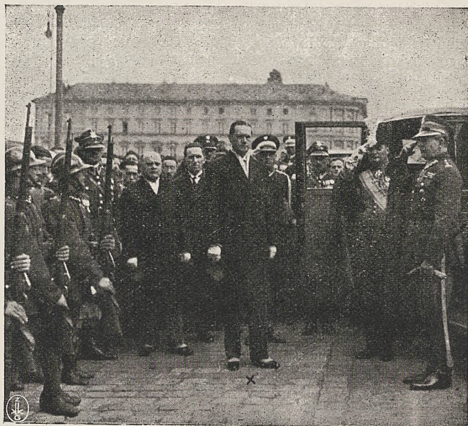
Nowy poseł nadzwyczajny i minister pełnomocny Łotwy w Polsce, p. Olgiert Groswald złożył wieniec w Warszawie na grobie „Niezanego Żołnierza”.
