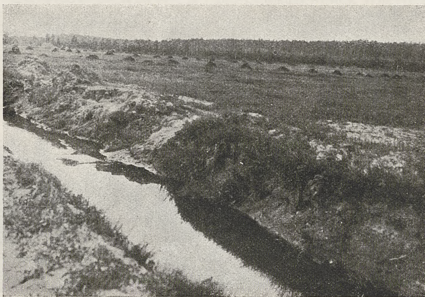
Kanal odwadniający przy meljoracji łąk w Chronowie
