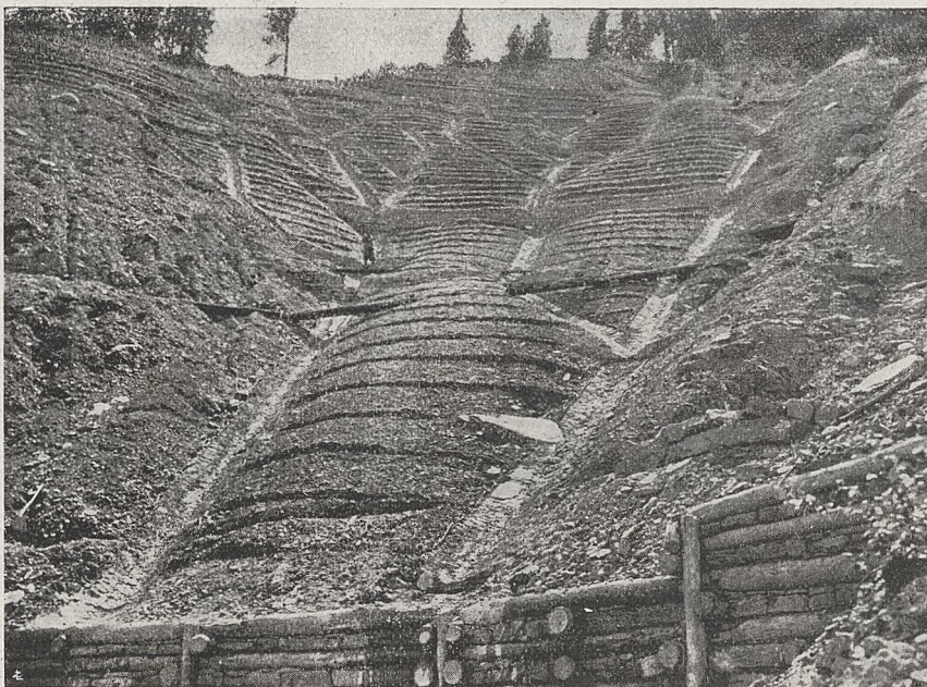
Zabudowanie potoku górskiego Rio Scuro
