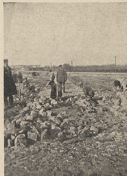
Odcinek szosy — Piaseczno — Zalesie, budowanej kosztem Stow. Przyjaciół Zalesia.
